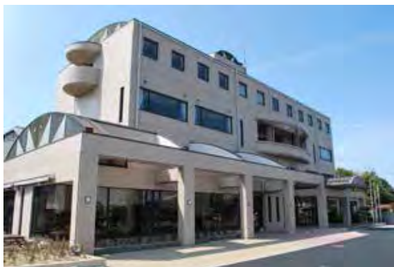
写真2 西条市地域創生センター
