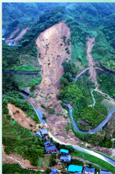
愛媛県、各地で土砂崩れ・氾川氾濫
