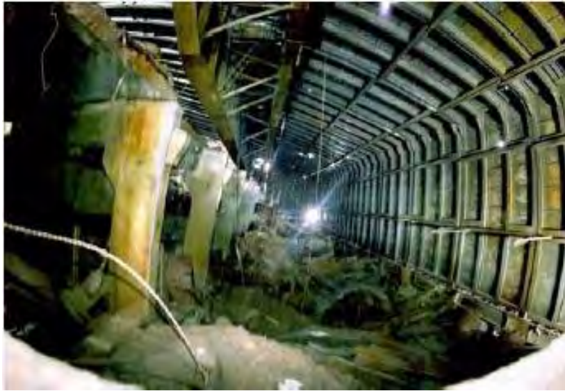
図 7.3.: 事故後の 4 号原子炉の内部の写真。[オリジナル]
