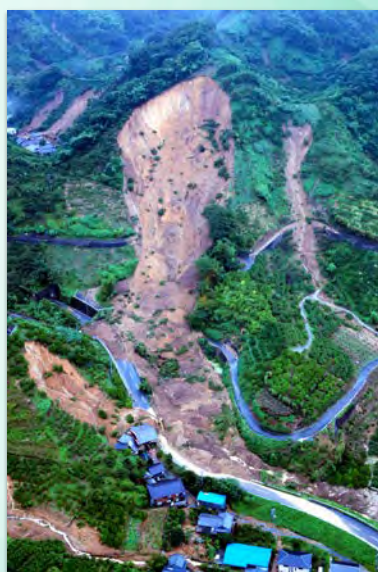
愛媛県、各地で土砂崩れ・氾濫
