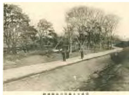
写真 1 完成せる渋谷川沿假道 路 (出典) 明治神宮奉賛会(昭和 12 年 8 月)『明治神宮外苑志』
