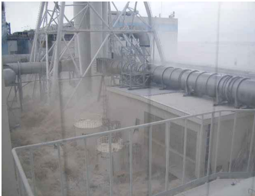
図参4-7. 写真17: 4号機周辺水没時 (写真8より1分50秒後)
