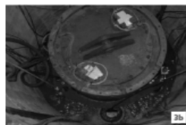
(b) 緩衝材除去後の写真
