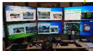
遠隔監視・操作室
