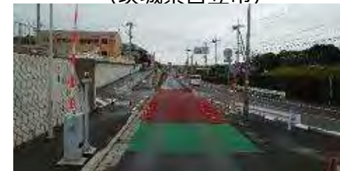
専用道の設備（茨城県日立市）17
