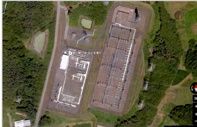
図 1-3. 水沢変電所上空からの写真。
