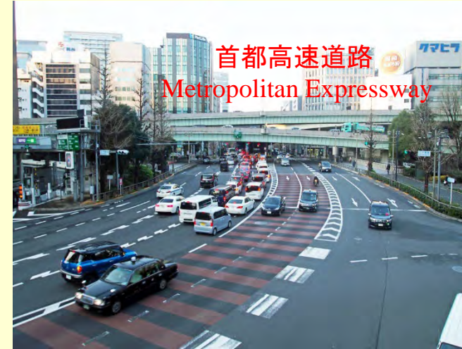
現在の昭和通りと江戸橋 Showa Dori Avenue and Edobashi Bridge today
