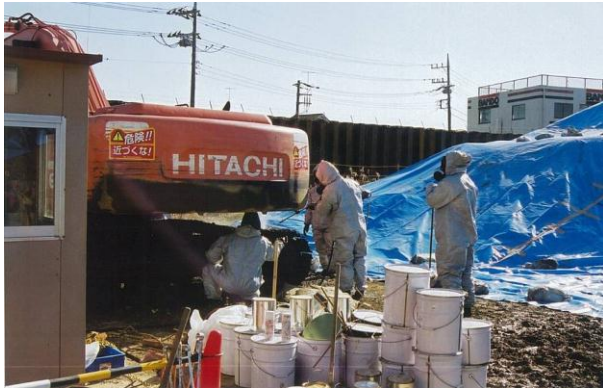
付図3 ジェット水による除染例
