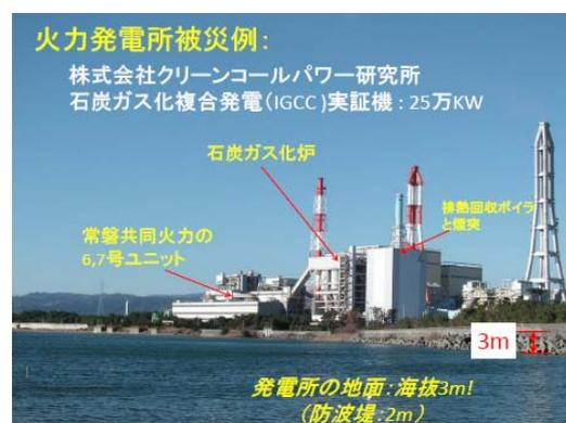
火力発電所被災例を紹介する。クリーンコールパワー研究所に世界最新鋭のIGCC(石炭ガス化複合発電)の25万kWのプラントがあるが、写真を提供いただいたので紹介する。発電所の地面は海拔3m、防波堤が2mである。
