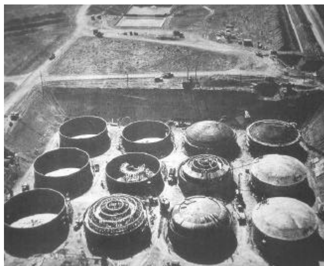
写真 2 . 4 - 3 建設中の高レベル廃液貯蔵タンク （文献(14)、Battelle Press の許諾を得て使用）
