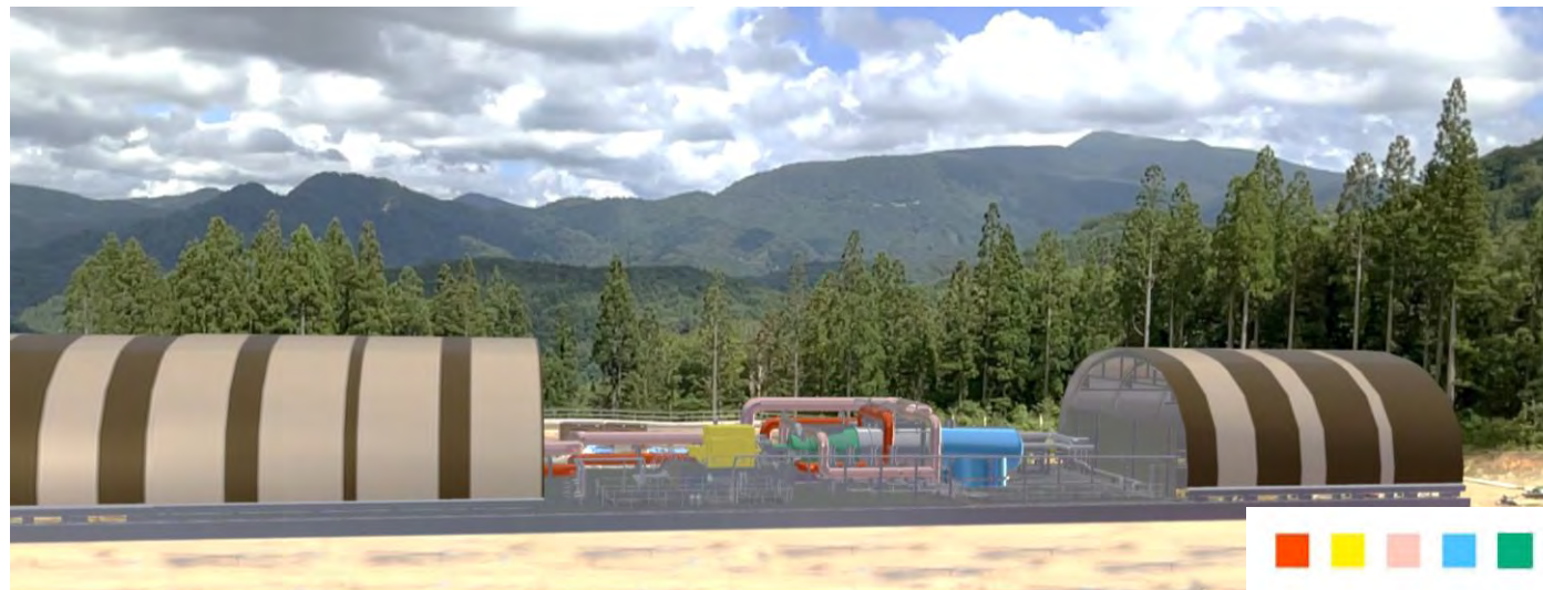
左：ドーム閉状態 右：開状態（現場写真との合成画像）
