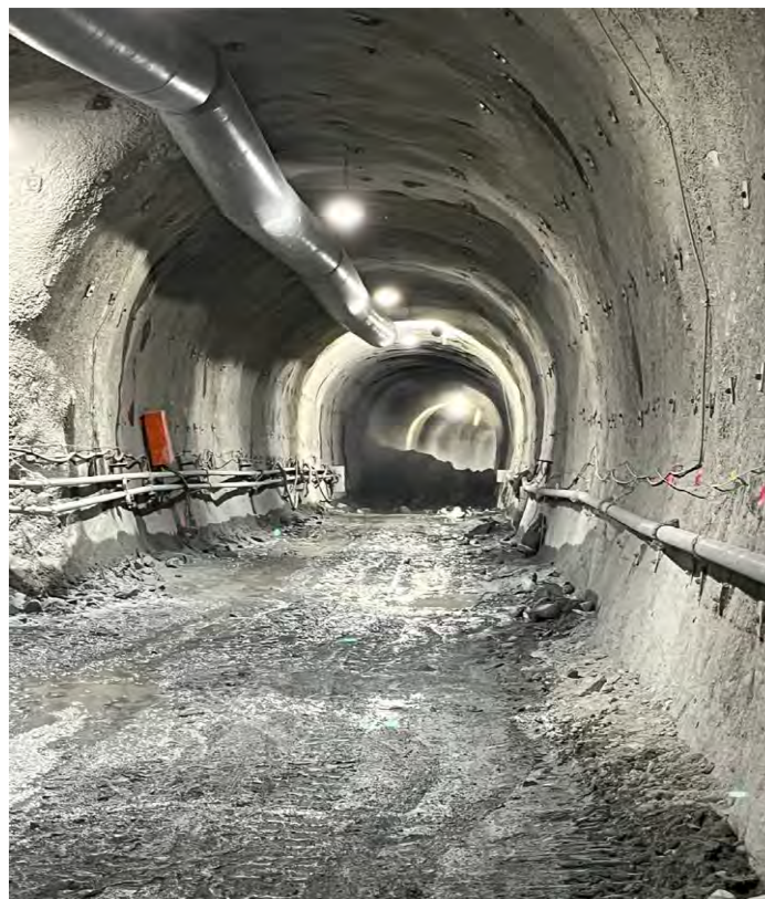
トンネル坑内
