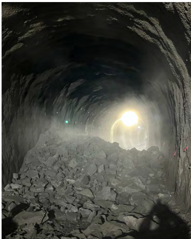
2024年12月12日貫通 坑内長：約860m 工期：約8か月
