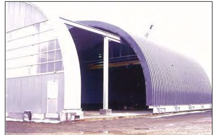
ドーム建屋(開状態)
