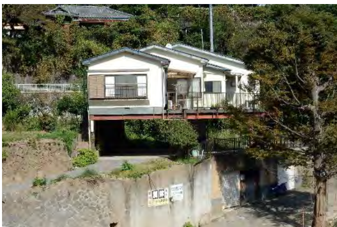
盛土とS造ピロティ混構造（軽微な被害）
