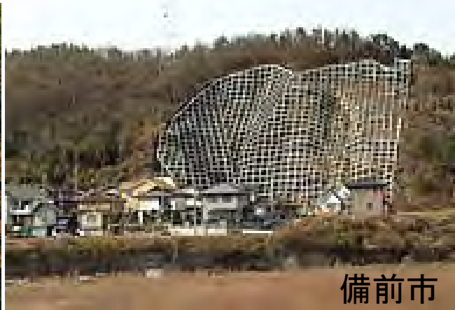
法枠・法面工(崖崩れ・地すべり)
