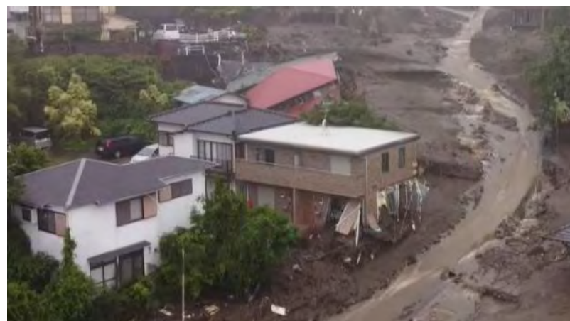
耐震等級3相当の軽量S造（流失せず）
