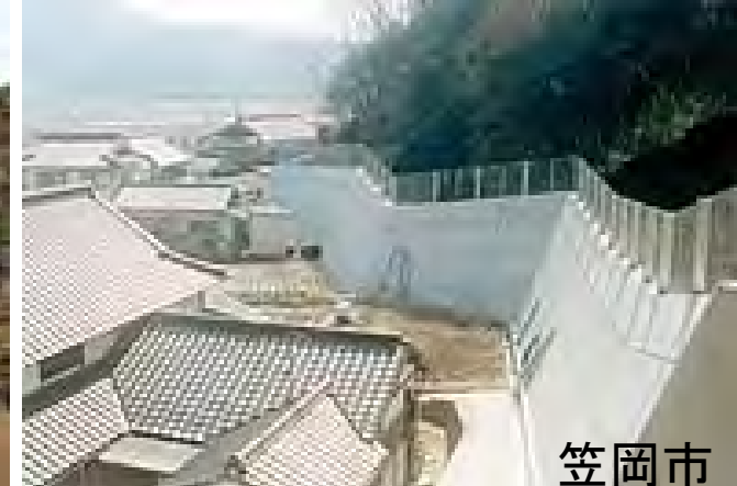
擁壁工(崖崩れ・地すべり)
