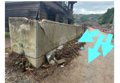
RC塀が家屋への作用力を低減（輪島市：2024年）
