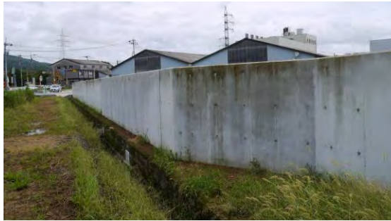
敷地周囲に設置した止水壁
