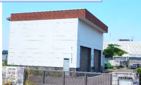
排水ポンプ施設を整備(15m 3 /s)
