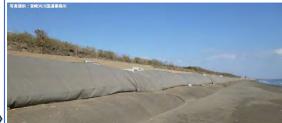
国土技術政策総合研究所・ナカタ産業(株)・前田工機(株)・三井化学産業(株) 共同研究 「海岸保全における砂袋詰め工の性能評価技術に関する研究」
