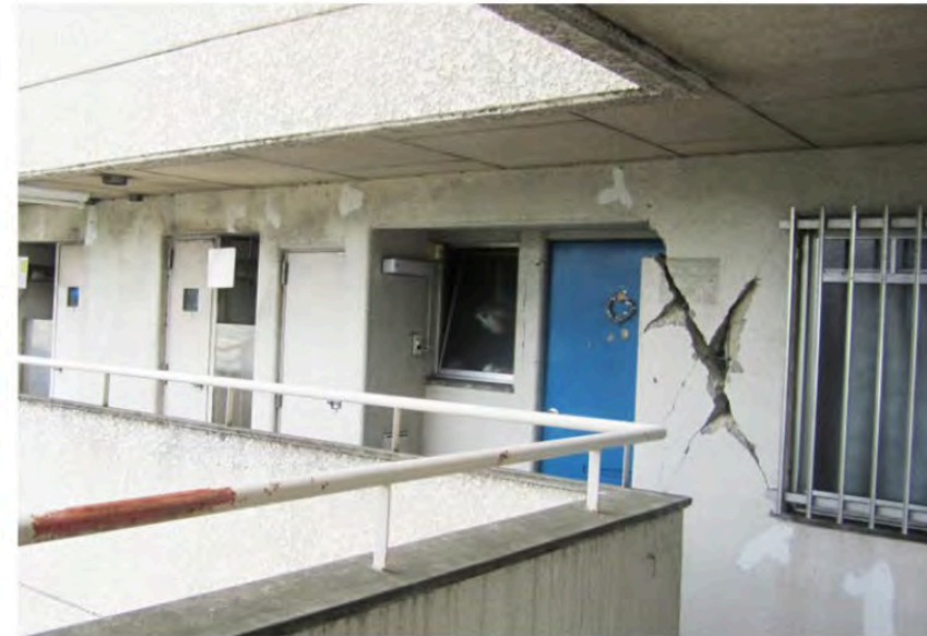
RC造被害例(2011東日本大震災)
