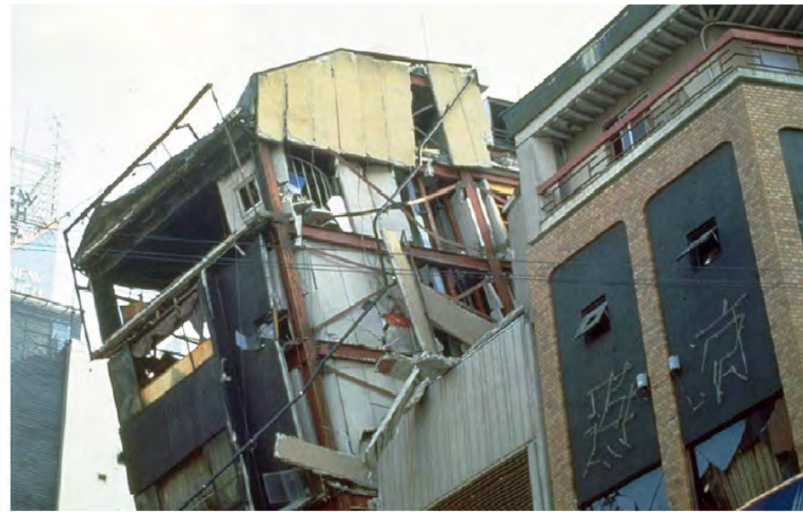
鉄骨造被害例 (1995阪神大震災)
