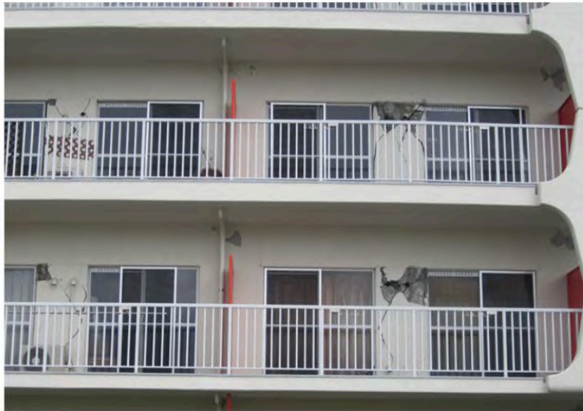
RC造被害例(2011東日本大震災)
