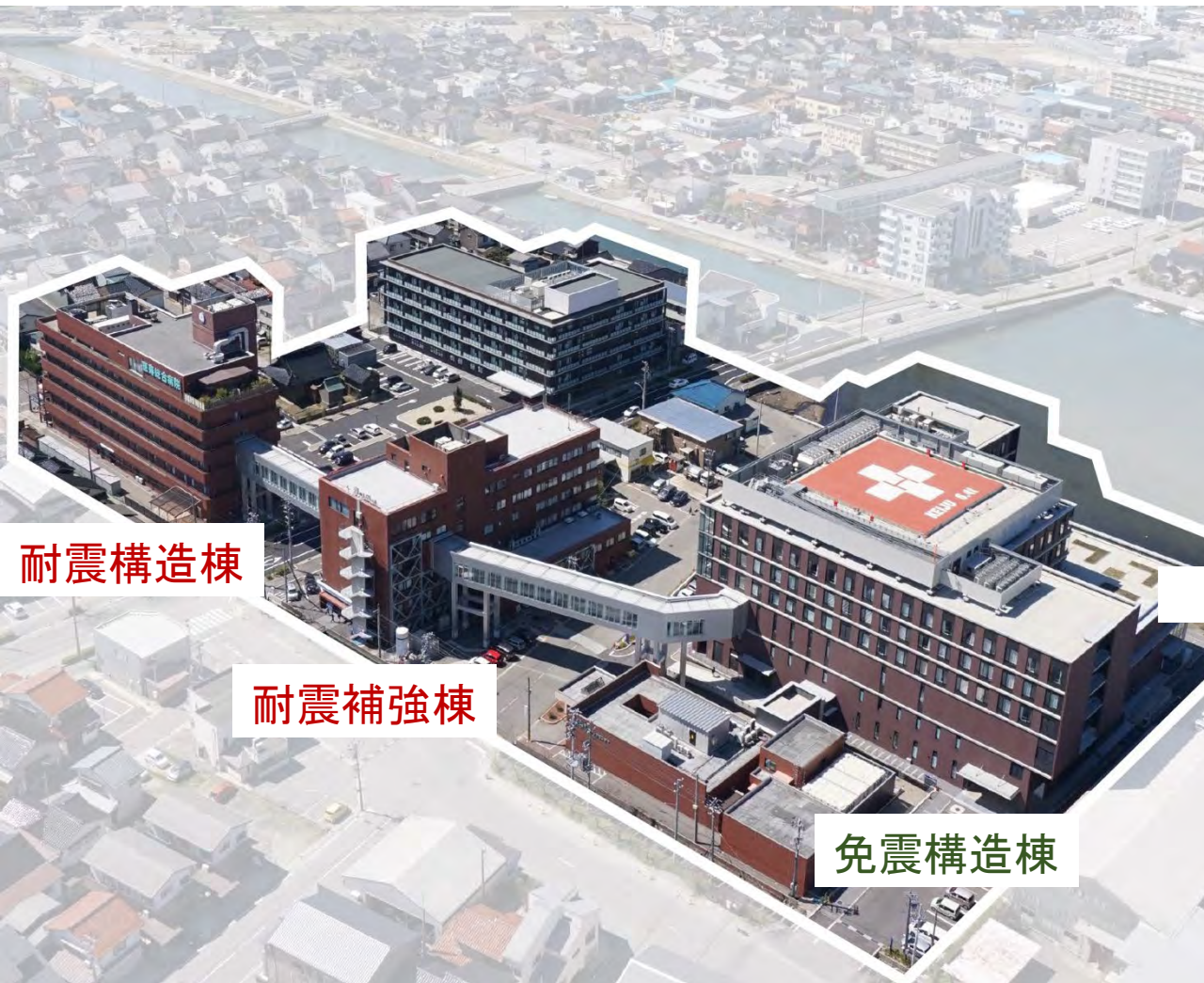
免震構造棟(被害なし、継続使用可能) Seismically isolated hospital main building
