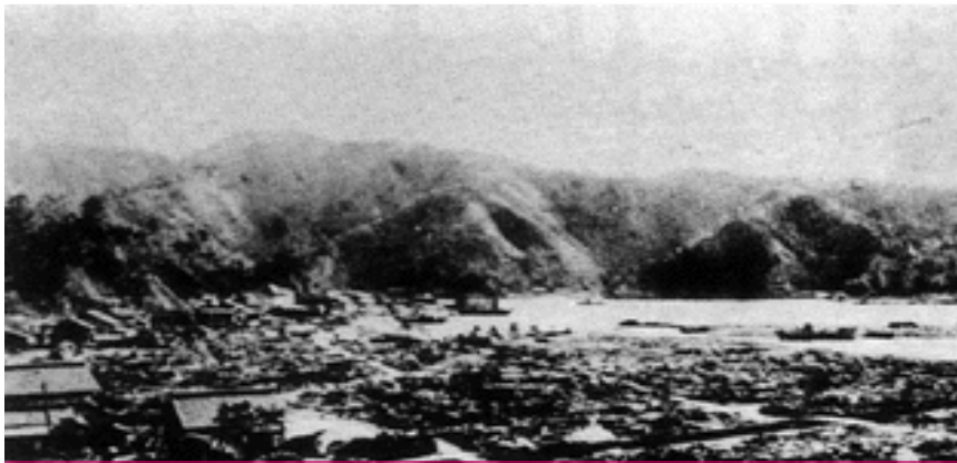
昭和19年（1944）12月7日の東南海地震による錦地区の津波被害状況（『くろしお 錦小学校創立百周年記念』より）
