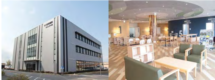
▲【新たな公共施設の脱炭素化】 (つくば市役所コミュニティ棟 ※ZEB Ready)
