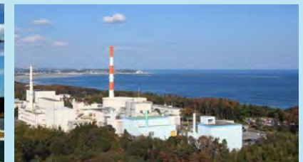
高速実験炉「常陽」
