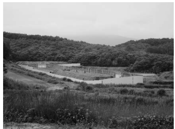
写真 除染廃棄物入りフレコンバッグの仮置き場 (2017年6月撮影)
