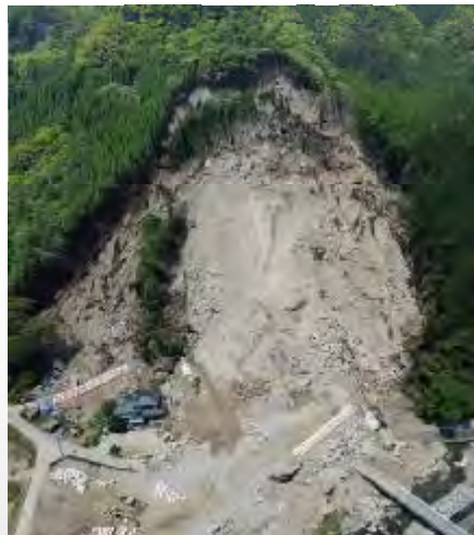
2018年4月中津市 耶馬溪斜面災害
