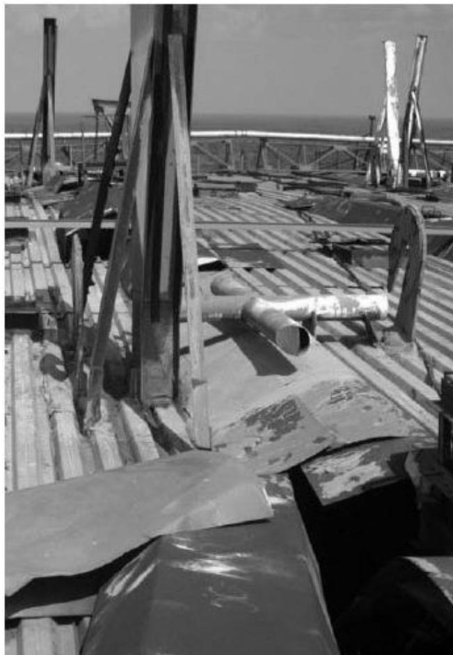
図 7.2.: 石棺シェルターの隙間が大気中水分の浸水を許している。[オリジナル] 【全部で  $1000\text{ m}^2$  ほどある隙間から雨水（英文では atmospheric water）が  $2000\text{ m}^3/\text{年}$  ほど石棺内（特に 4号原子炉）に侵入する。この湿気の為に腐食と放射能漏れが進んだ。】
