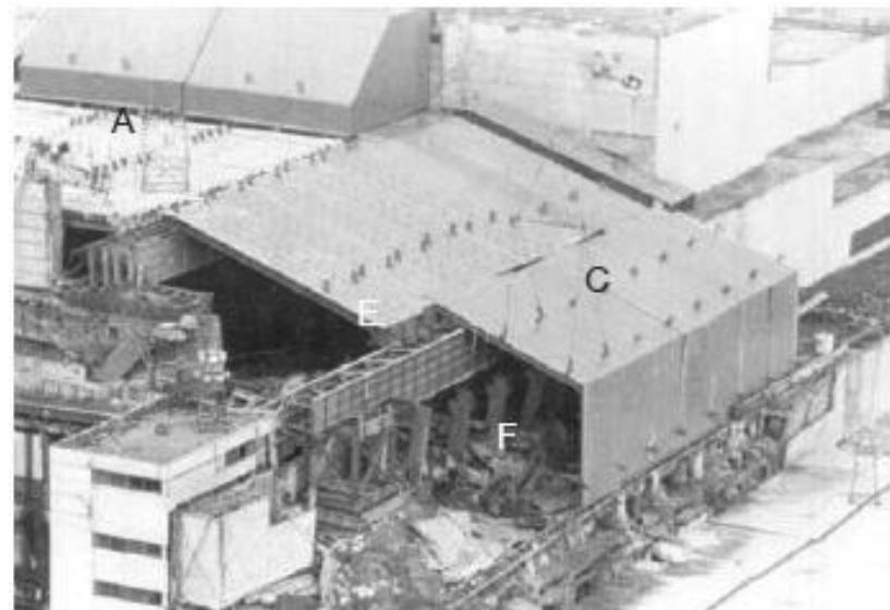
図 7.4.: 石棺シェルターの基本構造【工事中の写真から】。(A)パイプルーフ工法 (pipe roofing) の屋根、(B)南側の壁、(C)南側にホッケーのスティックのように貼り出した屋根 (hockey stick)、(D)地下 1 階、地下 2 階の鉄骨梁、(E)巨大な鉄骨梁、(F)タコ足型の鉄骨梁。[オリジナル]
