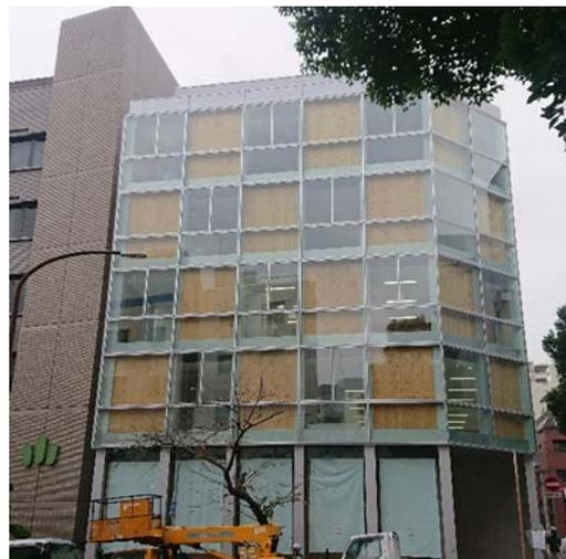
図9 鉄骨造と CLT 壁を併用した構造（左：内部 右：完成後）
