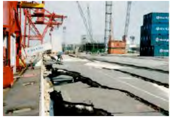
兵庫県南部地震時の護岸の側方流動
