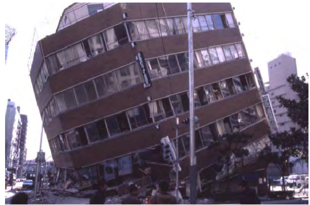
兵庫県南部地震で倒壊した建物
