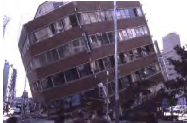
阪神淡路大地震中倒塌的建筑物
