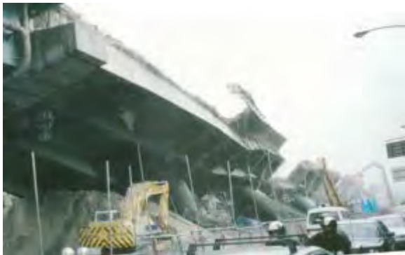
阪神淡路大地震中高速公路的倒塌 摄影: 高桥良和
