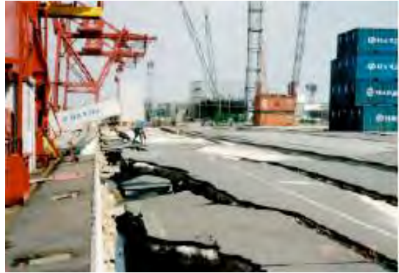
阪神淡路大地震时堤岸发生侧向流动
