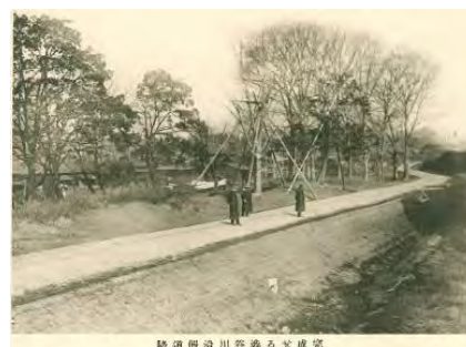
写真 1 完成せる渋谷川沿假道路
