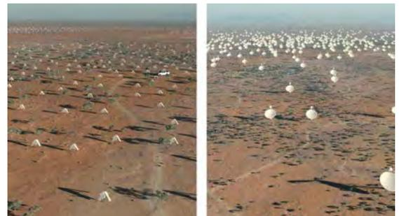
図2: SKAの完成予想図。左は低周波SKAの開口型アンテナ、右は中間周波SKAのパラボラアンテナ。
