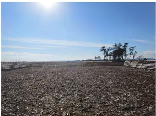
写真5 津波廃棄物の盛土による基盤整備
