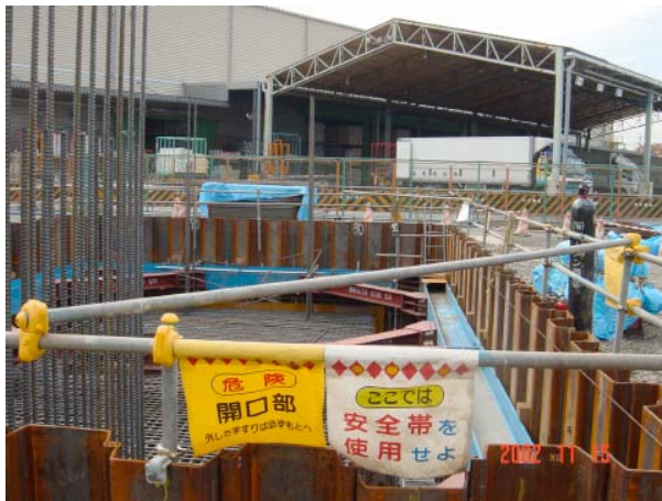
写真3. 1 マスター入り瓶が掘削された 橋脚工事現場
