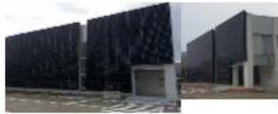
カネカ エンジニアリングセンター(高崎工業団地内)
