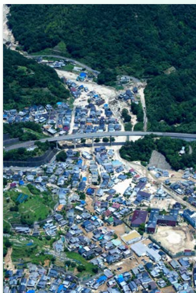
広島県坂町の土砂災害
