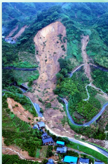
愛媛県、各地で土砂崩れ・氾川氾濫
