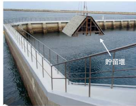
貯留堰の設置工事
