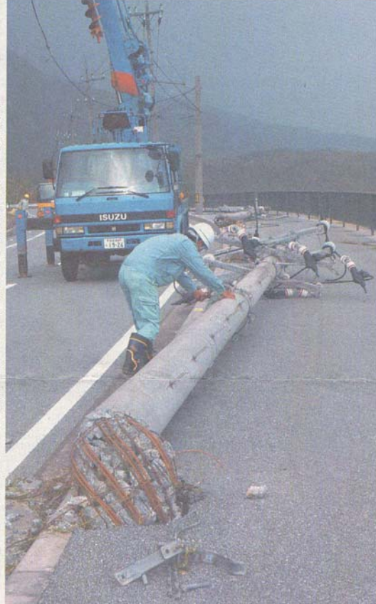
暴風でなぎ倒された電柱の復旧に当たる作業員。19日午前9時50分ごろ、竹富町西表島
