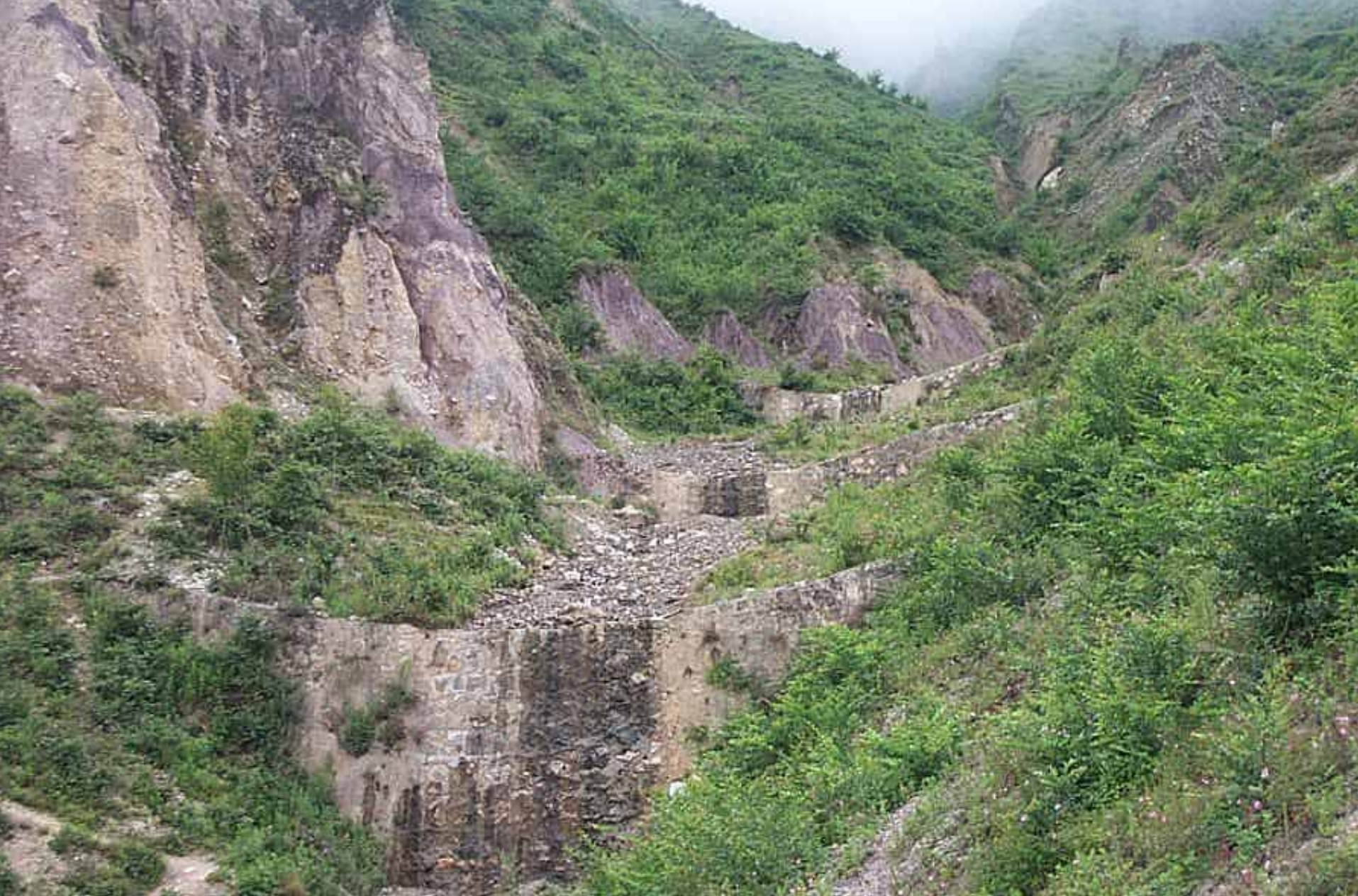
多照支沟二上的控制工程 (1966)-debris flow control dam train
